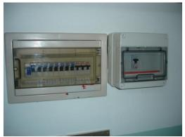
Al piano terra, in prossimità dell'ingresso sul lato destro è presente il quadro elettrico generale dell'edificio da dove sarà possibile, agendo sull'interruttore generale, effettuare lo sgancio dell'intero impianto elettrico. In caso di effettiva emergenza è possibile interrompere l'erogazione dell'energia elettrica agendo sui pulsanti di sgancio con vetro a
